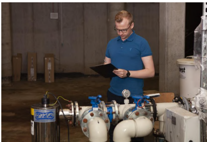
Obraz 5: Przegląd instalacji wodnej może zostać wykonany samodzielnie. Można go również zlecić doświadczonemu ekspertowi. Na zdjęciu Bartosz Korwin, specjalista ds. bezpieczeństwa wodnego BlueCare podczas przeglądu instalacji wodnej.
