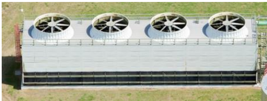
Obraz 21: Zespół wież chłodniczych. Na szczycie widoczne są wentylatory wspomagające wymianę powietrza.
